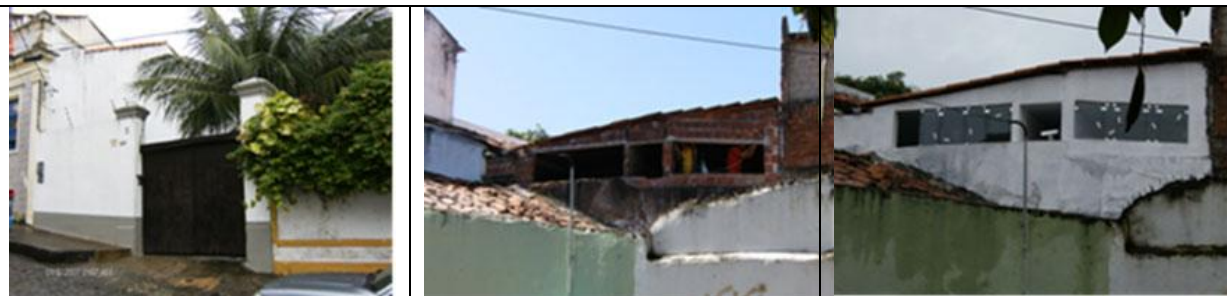
Figura 10 - Construção de anexo ao Imóvel de nº 322 situado na Rua Bernardo Vieira de Melo (Ladeira da Ribeira)
