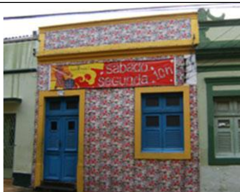
Fachada da casa nº 278, Rua Prudente de Moraes
