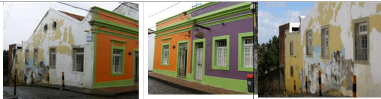
Figura 11 - Reforma com ampliação de área construída dos imóveis de nº 329 e 335 (Restaurante Oficina do Sabor) situados na Rua do Amparo
