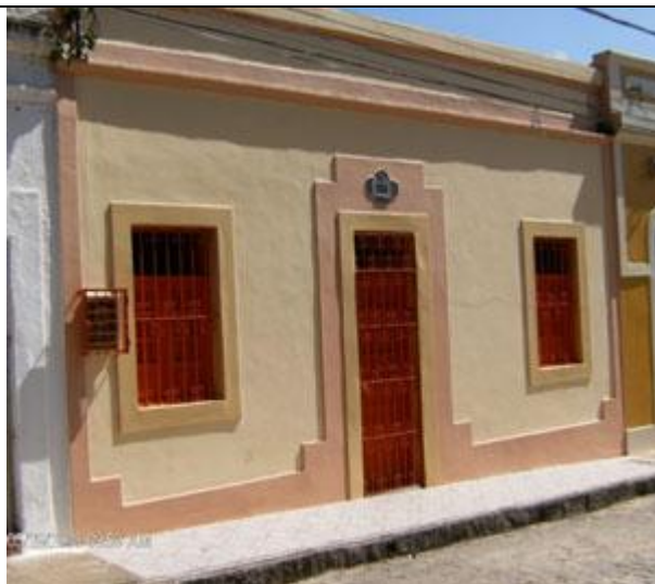
Figura 7 - Intervenção de reforma da casa nº 259 da Rua 13 de Maio
