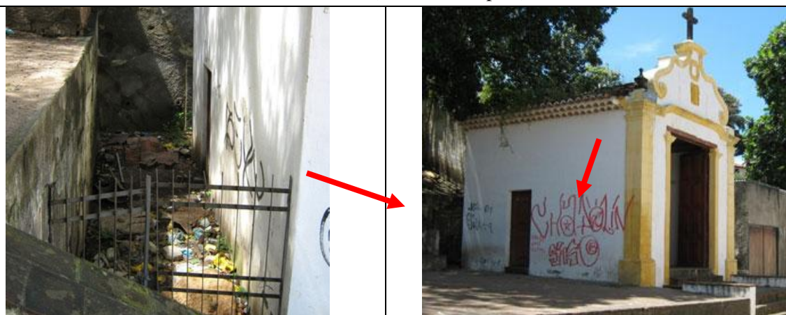
Setembro de 2008 (fundos da Capela: presença de lixo, pichações)
